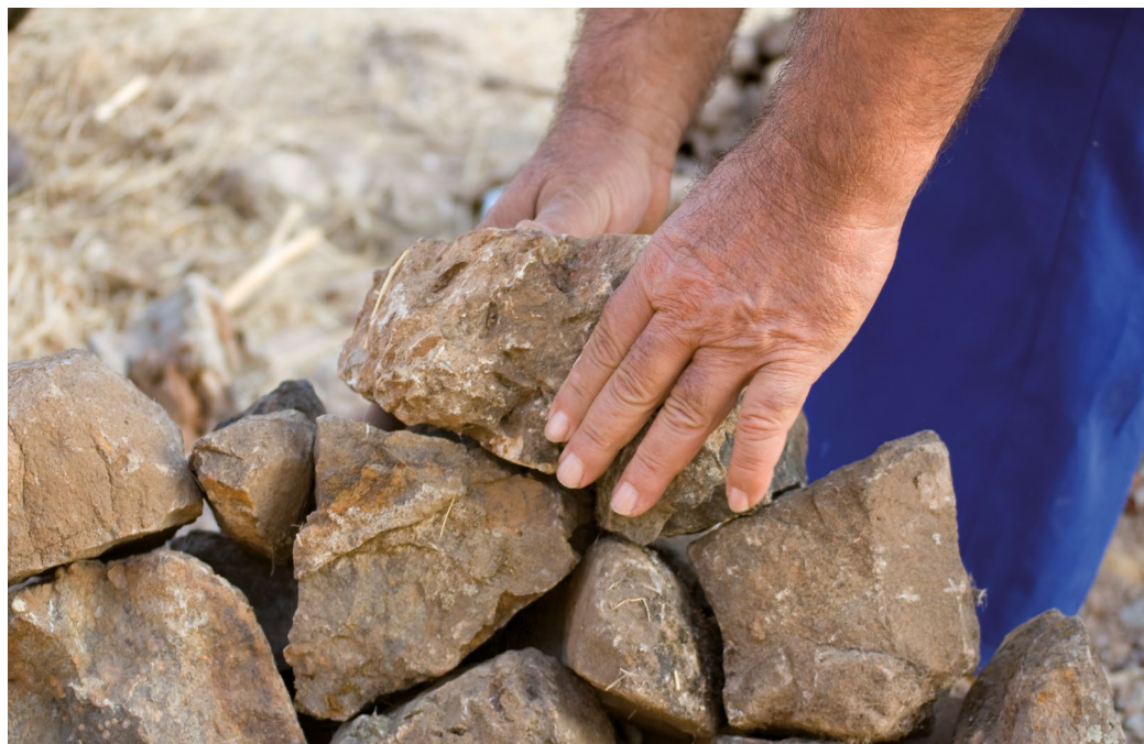
Construyendo muro de piedra seca, Alanís, Sevilla (Alessandra Olivi)
